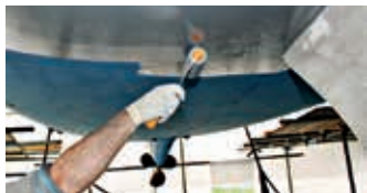
Hempel's High Protect II mit einer Schaumstoffrolle auftragen
