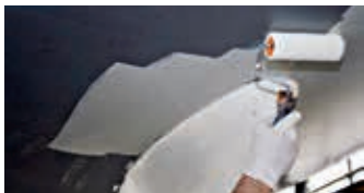
Antifouling auf Primer auftragen
