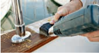
Alten Lack mit Heißluftpistole entfernen
