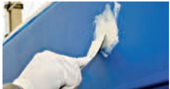
Einzelne Stellen mit Spachtelmesser bearbeiten
