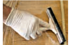
Verschmutztes Wasser entfernen
