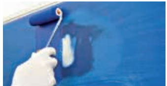
Primer auf einzelne Stellen auftragen
