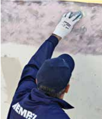
Spachteln entlang der Wasserlinie
